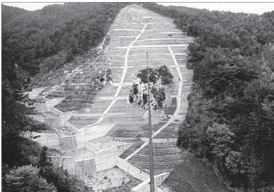
▲山崩れ跡地の復旧工事直後の様子（香川県小豆島）
